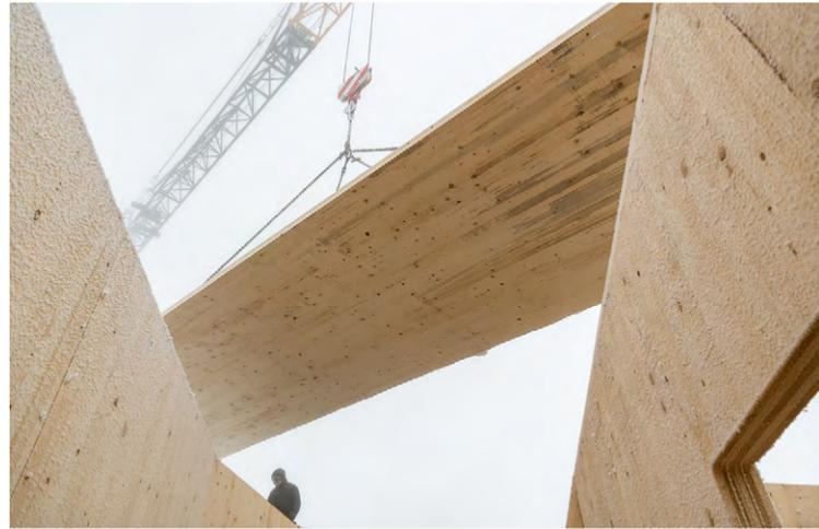
Ab dem Erdgeschoß werden die vier aufgehenden Geschoße mit Holzfertigteilen errichtet. Für Innenwände und Geschoßdecken werden massive Kreuzlagenelemente eingesetzt. Die vertikale Gebäudehülle wird geschosswise aus gedämmten Ständerwänden aufgebaut; Ende September 2016
